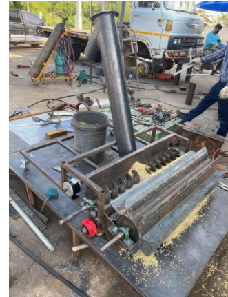
ภาพที่ 5 ติดตั้งมอเตอร์ DC 24 โวลต์
